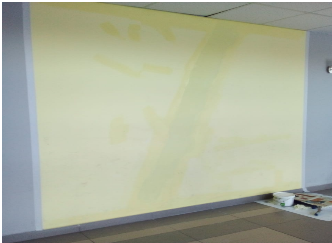
Косметический ремонт холла 1ый этаж
