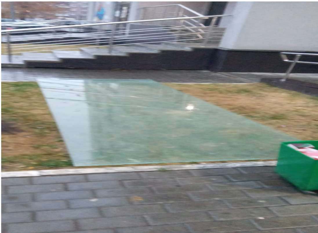
Замена разбитого козырька над входной группой
