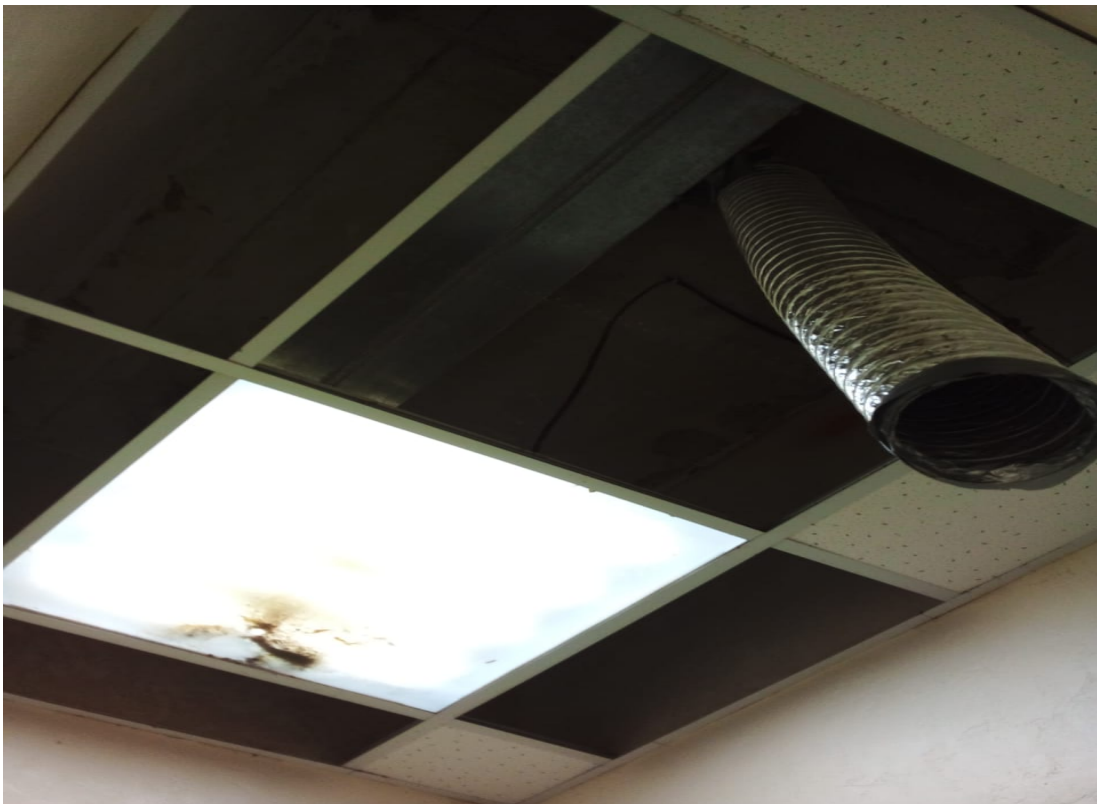
Ремонт подвесного потолка
