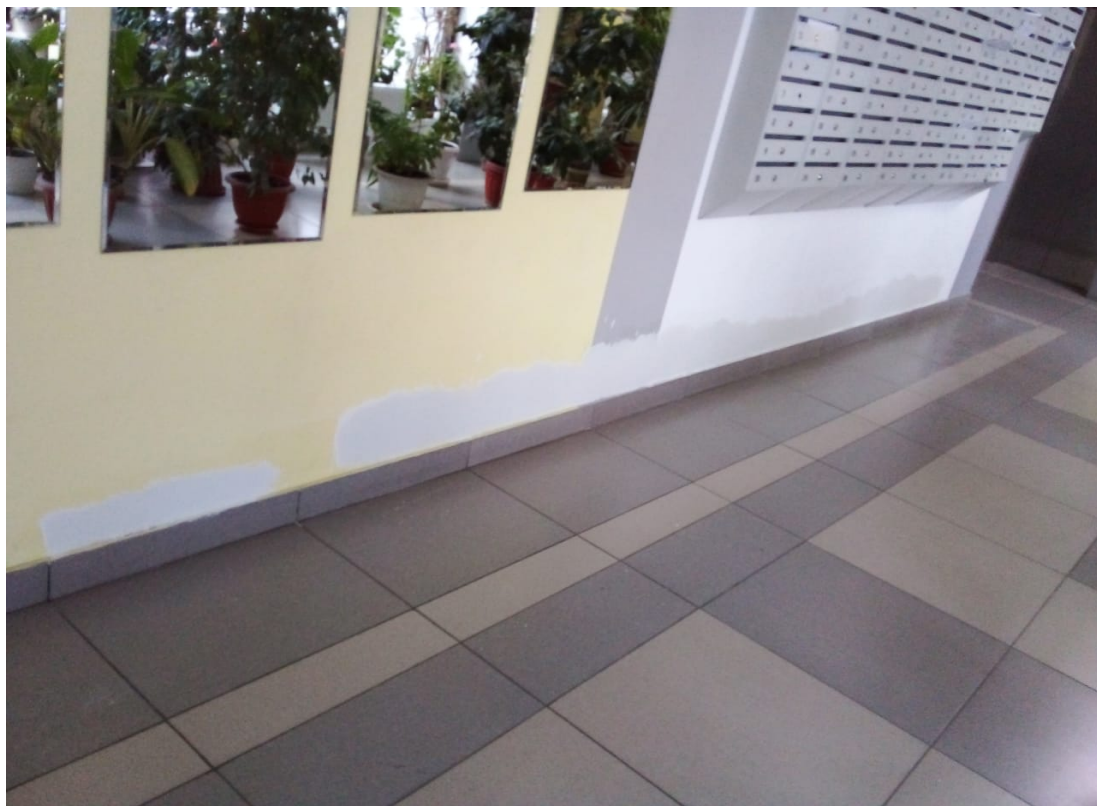
Косметический ремонт холла 1ый этаж
