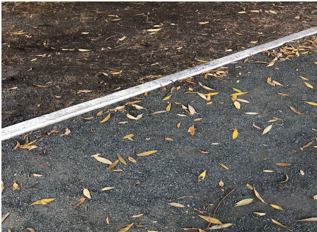
Монтаж новой архитектурной формы
