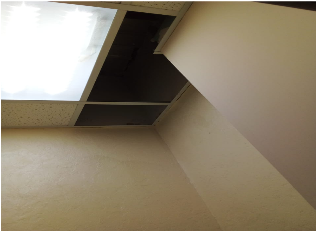
Ремонт подвесного потолка
