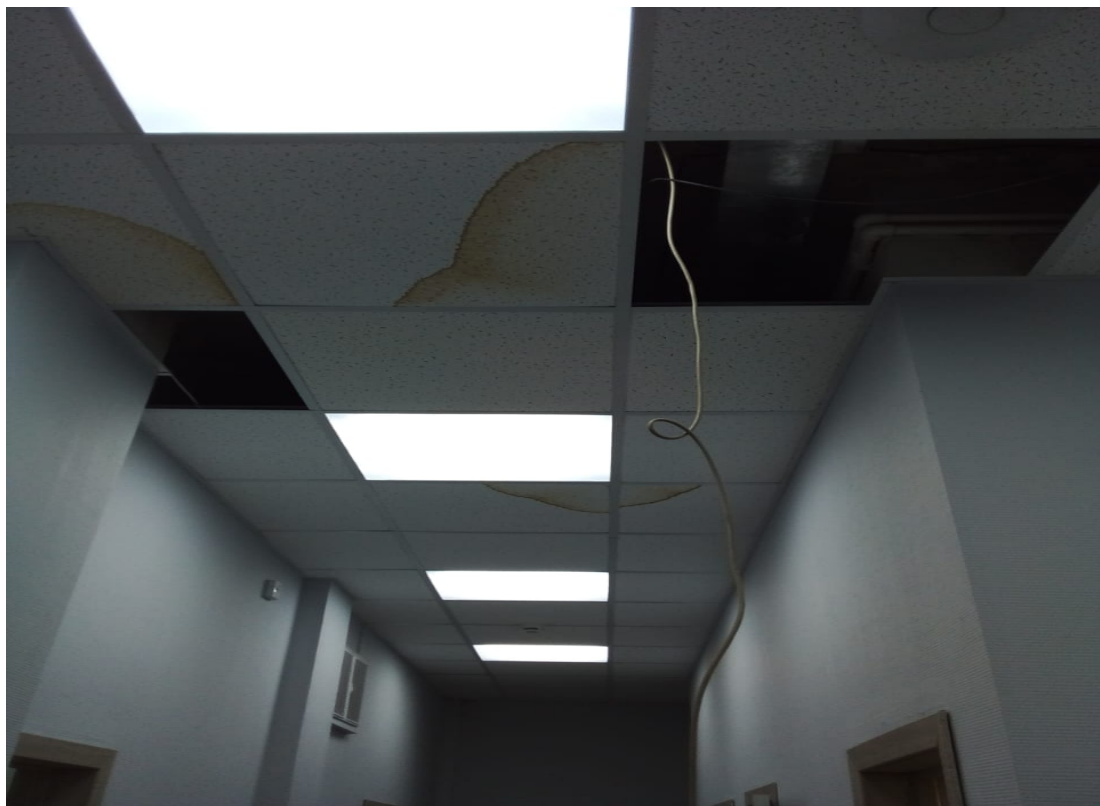
Ремонт подвесного потолка
